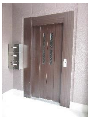
エレベーター
