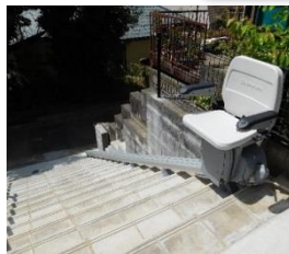
昇降機リフト
