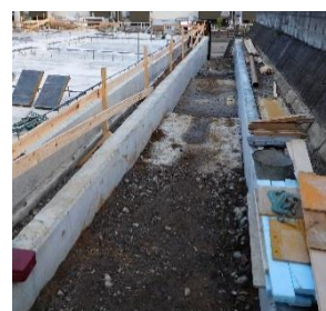
スロープの設置部分です。
