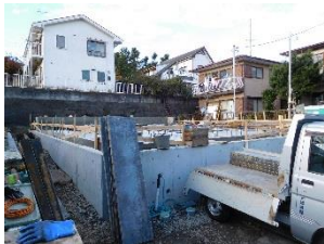
11月28日 現在の工事の様子です。
