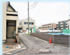
▲事務所入り口(上) 工房前の工事状況(下)
